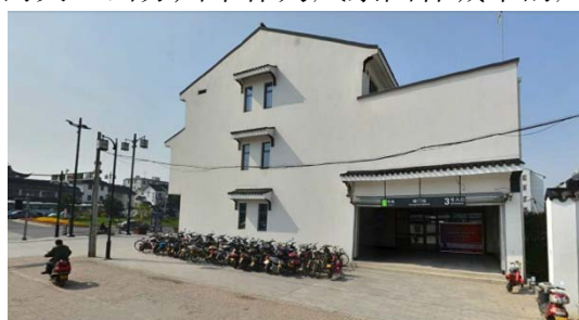
与古建筑风貌融合较好的相门站出入口
