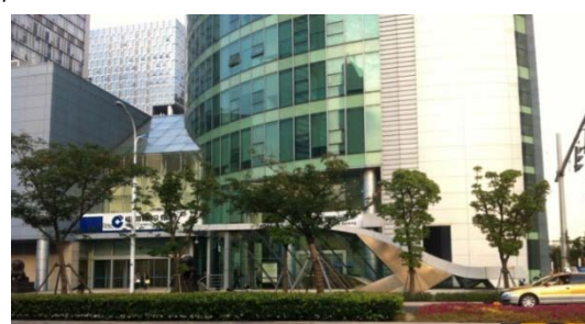
与背景建筑融合较好的中央公园站出入口
