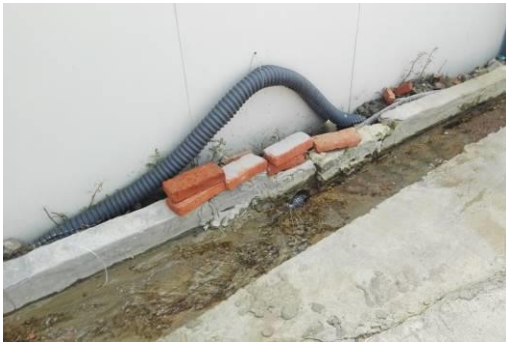
施工营地排水沟
