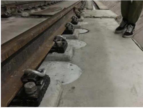
特殊减振（高档钢弹簧浮置板道床）
