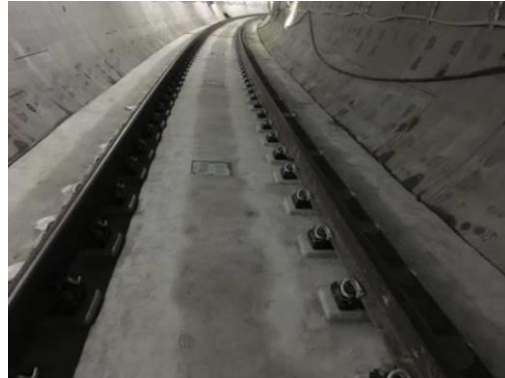
出入场线钢弹簧浮置板道床
