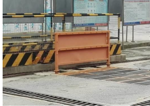
车辆冲洗平台
