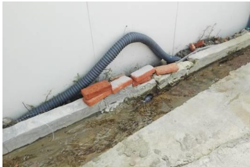
施工营地排水沟
