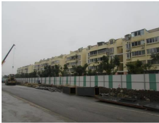
施工现场围挡
