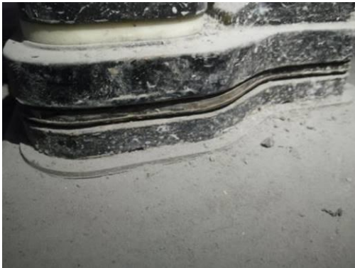
中等减振（压缩型减振扣件）
