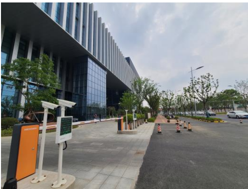
控制中心内部道路
