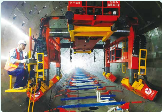
采用装配式轨道技术施工
